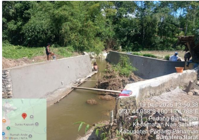
Rehabilitasi Jaringan Irigasi D.I. Sigabue Toboh Ketek
