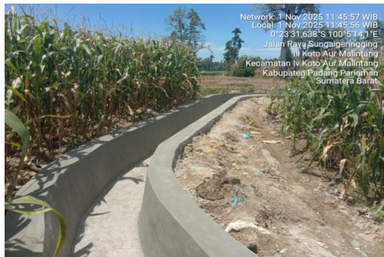
Rehabilitasi Jaringan Irigasi D.I. Banda Piliang
