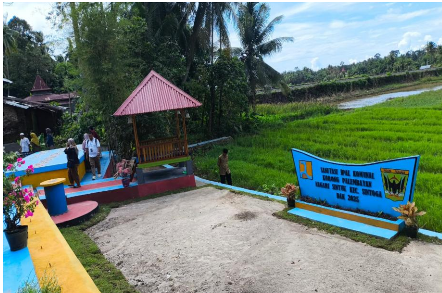
IPAL Komunal Korong Palembang Nagari Sintuk Kecamatan Sintoga
